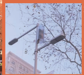
スマートライティング 交通量のセンサ情報を小電力無線のセンサ・Wi-Fiでコントローラに送り、エリアを適切な照度に調整。省エネを実現し、電気代の削減につながる
